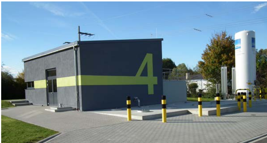
Abb. 8: Außenansicht der 4. Reinigungsstufe in Weißenburg
