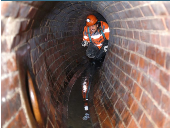
Abb. 5: Kanalinspektion durch Begehung
