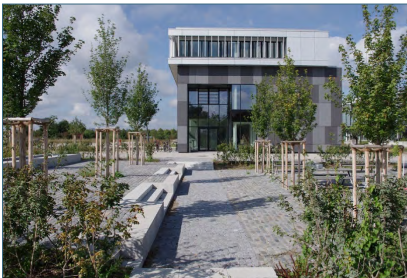
Abb. 4: Laborneubau mit Außenbereich Kantine
