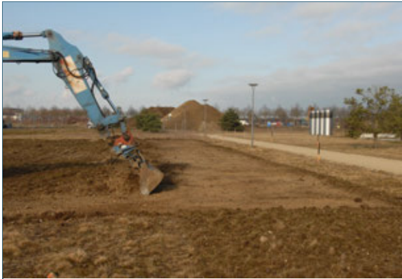
Abb. 2: Vorbereitung des LfU-Neubaus
