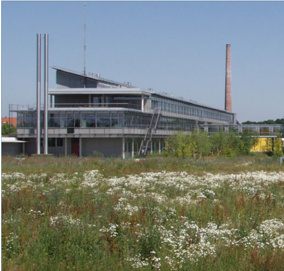
Abb. 1: Altes Laborgebäude Westseite
