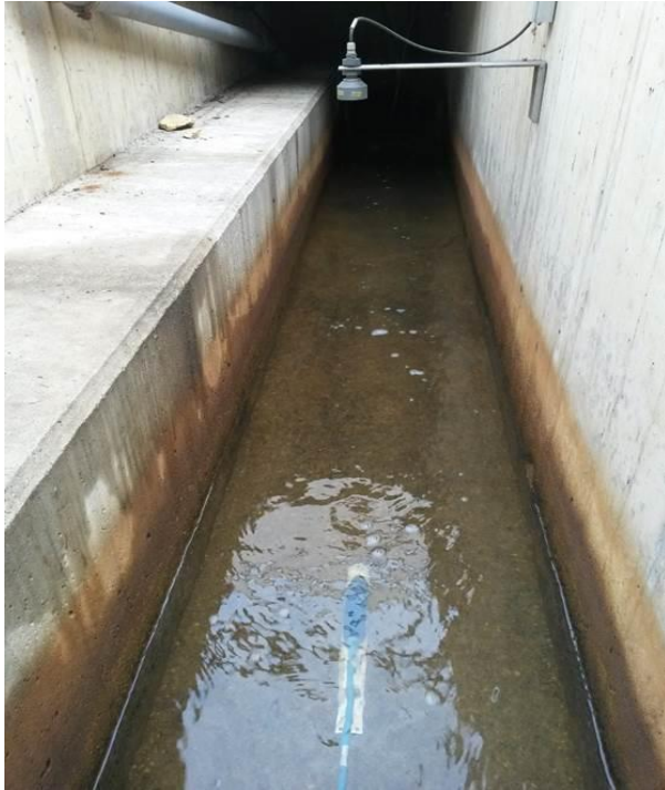
Abb. 10: Beispiel Ultraschall-Dopplerverfahren in einem Gerinne
