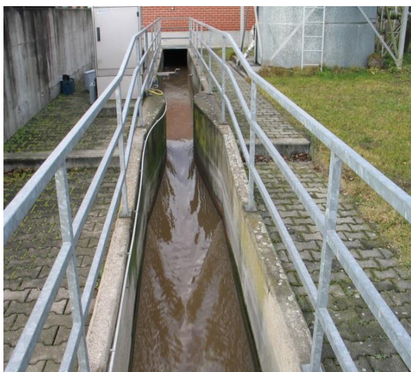
Abb. 6: Beispiel eines Venturi-Gerinnes
