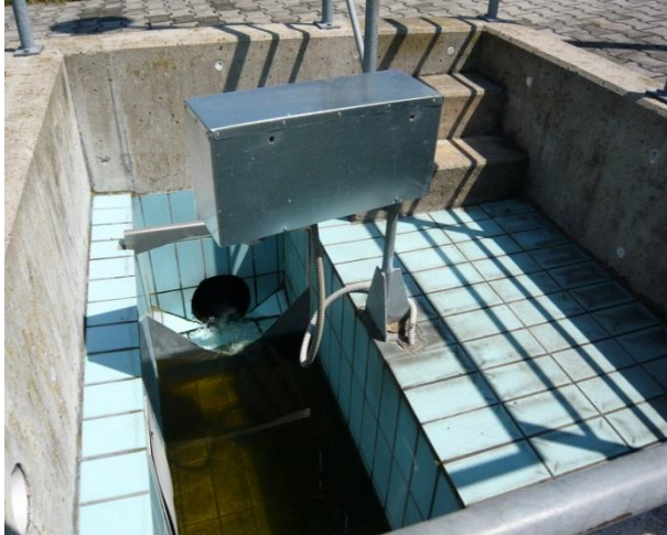
Abb. 3: Dreieckmesswehr in Betrieb
