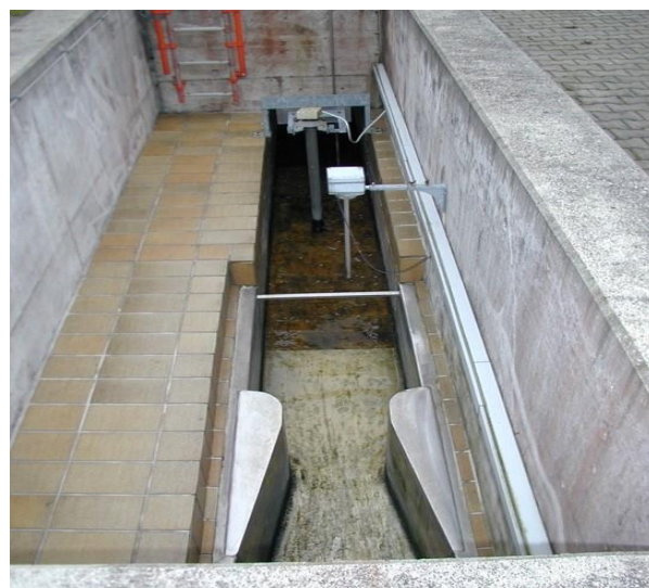
Abb. 7: Beispiel eines weiteren Venturi-Gerinnes
