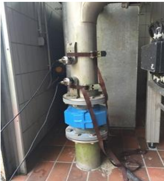
Abb. 9: Beispiel eines Aufschnallgerätes (Clamp-On)
