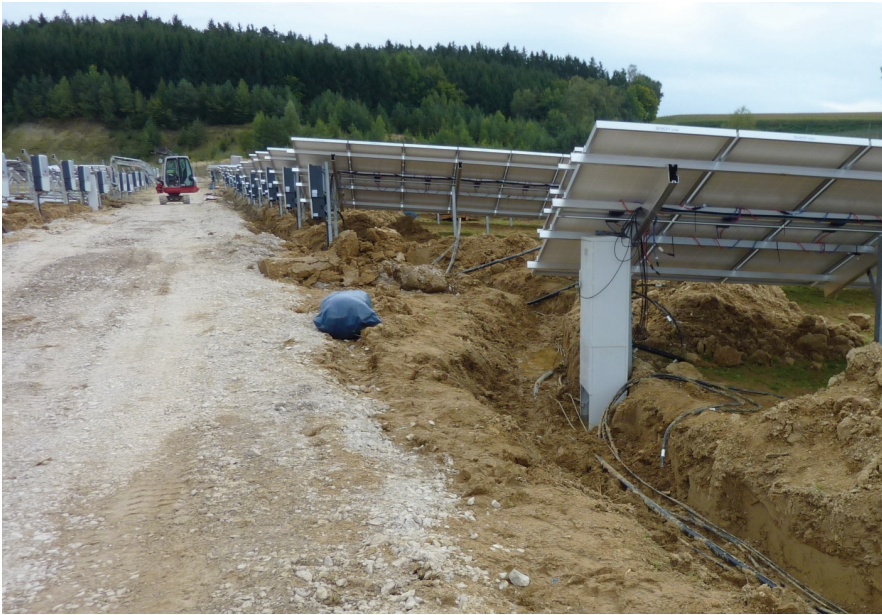
Abb. 1: Errichtung einer Freiflächenphotovoltaikanlage (Bildquelle: Hallertauer Handelshaus GmbH)
