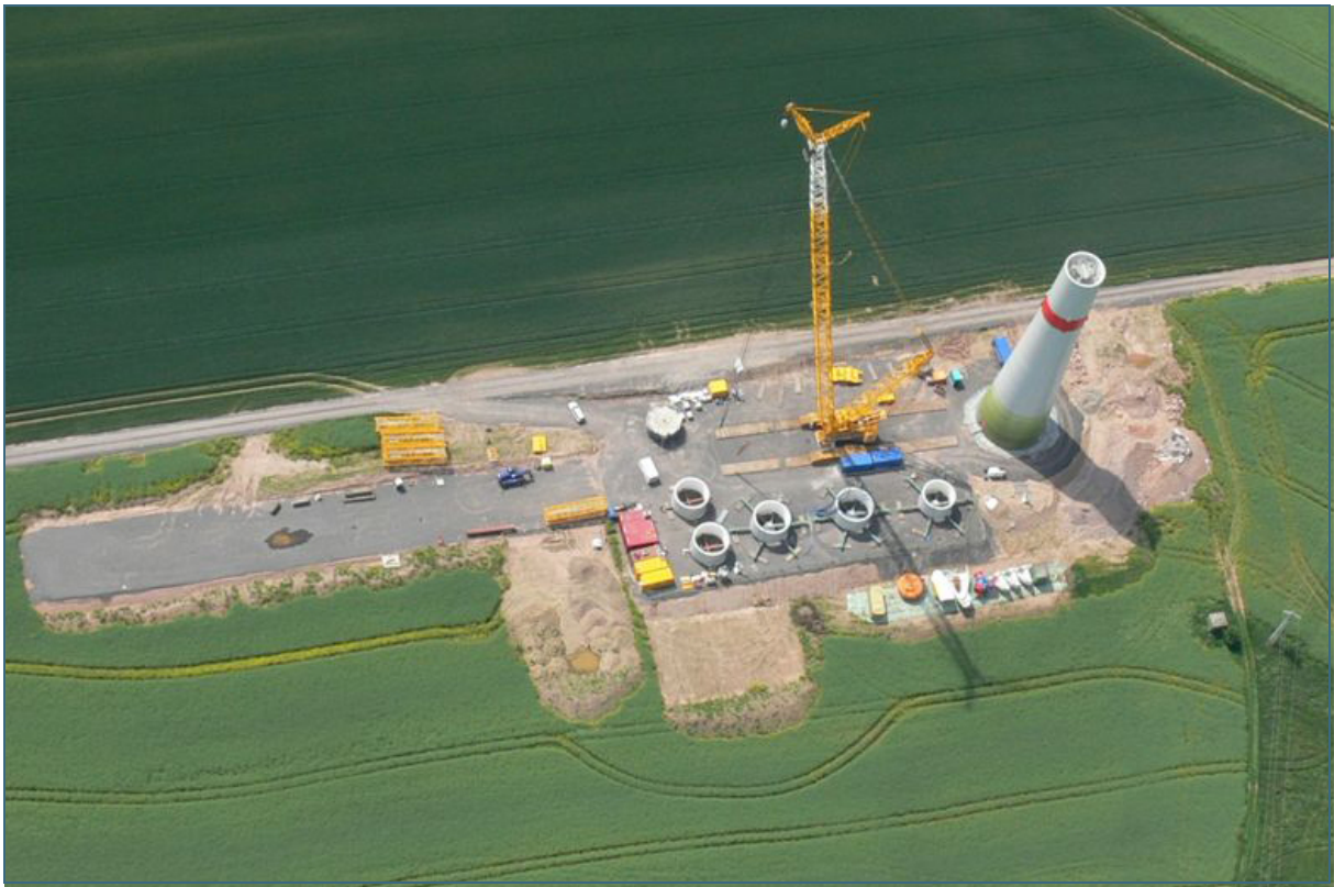
Abb. 1: Baustelle zur Errichtung einer WKA (Bildquelle: Juwi Holding AG)
