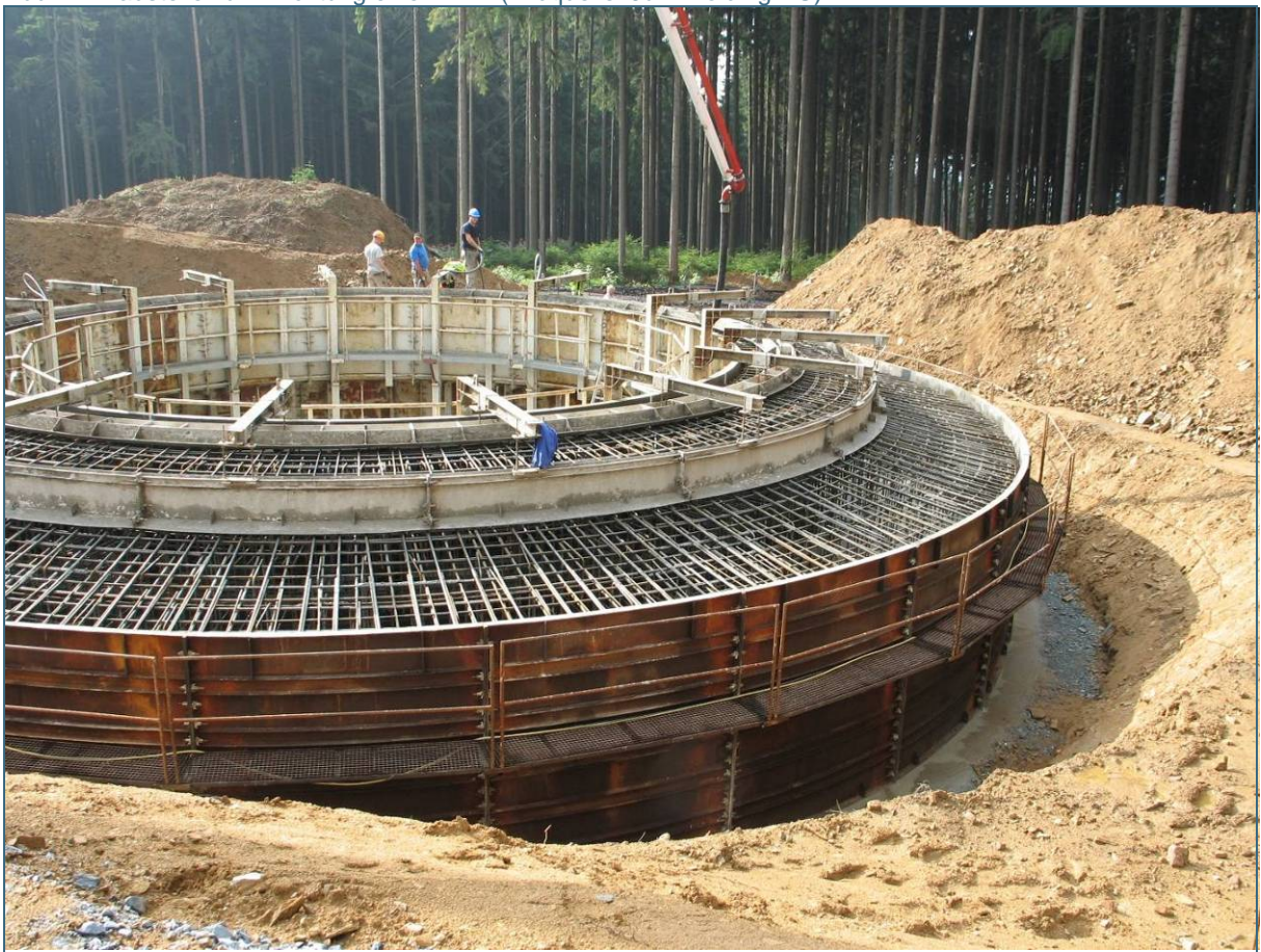
Abb. 2: Fundamentbau für eine WKA (Bildquelle: LfU)
