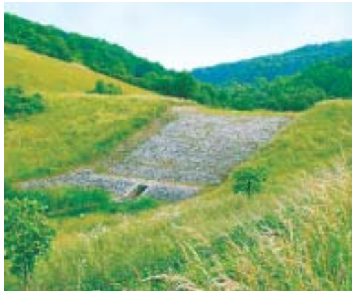
Beispiel für einen Rückhalt in einem Hochwasserrückhaltebecken: Hochwasserschutz Hausen
