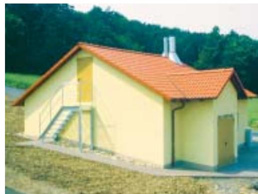
Mit Pflanzenöl betriebenes Blockheizkraftwerk in der Gemeinde Greußenheim, Landkreis Würzburg
