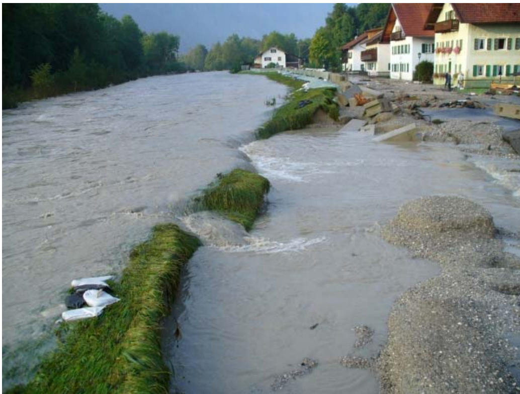
Abbildung 4-9: Deichüberflutung in Eschenlohe an der Loisach am 24.8.2005. Quelle: WWA Weilheim
