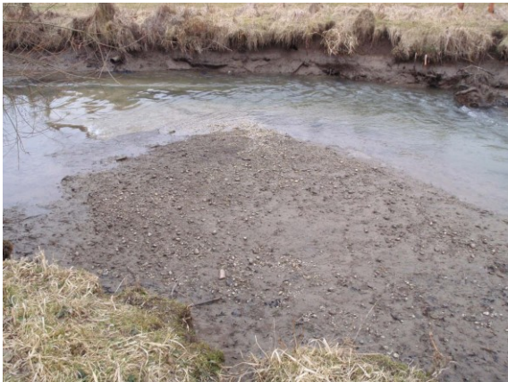
äußere Kolmation einer Kiessohle
