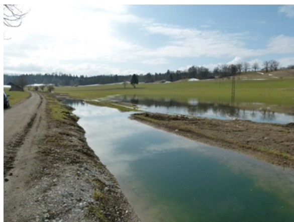
Abb. 27: Schaffung von ca. 12.000 m³ Retentionsraum (Hochwasser während der Bauzeit)
