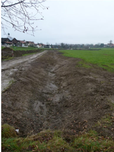
Abb. 33: Gewässeraufweitung mit Niedrigwasserrinne- Bau- phase
