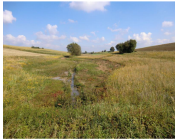
Abb. 20: Zettelbach (Abschnitt): Ökologische Aufwertung des begradigten Seitengewässers und Abrücken der landwirtschaftlichen Nutzung vom Gewässer
