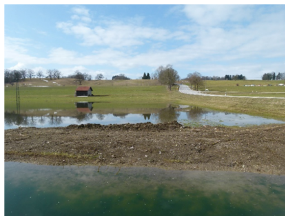
Abb. 28: Schaffung von ca. 12.000 m³ Retentionsraum (Hochwasser während der Bauzeit)
