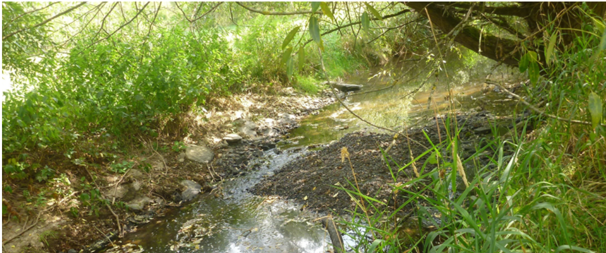
Abb. 17: Schüttung von abgestuftem Kies zur Bachbettverengung und Schaffung eines tieferen Bereichs (Bild: Hagen Rothemund)
