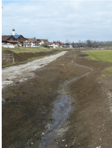
Abb. 34 Gewässeraufweitung mit Niedrigwasserrinne:-nach Fertigstellung
