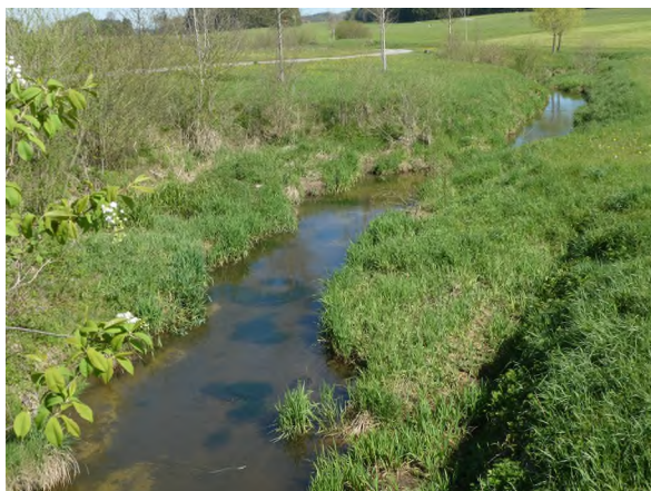
Abb. 25: Braunau: Aufweitungen oberhalb der Mittelwasserlinie entlasten bei Hochwasser das Gewässerbett und verringern so die Drift von Jungfischen; eine Ringelnatter überquert den Bach (im Vordergrund)
