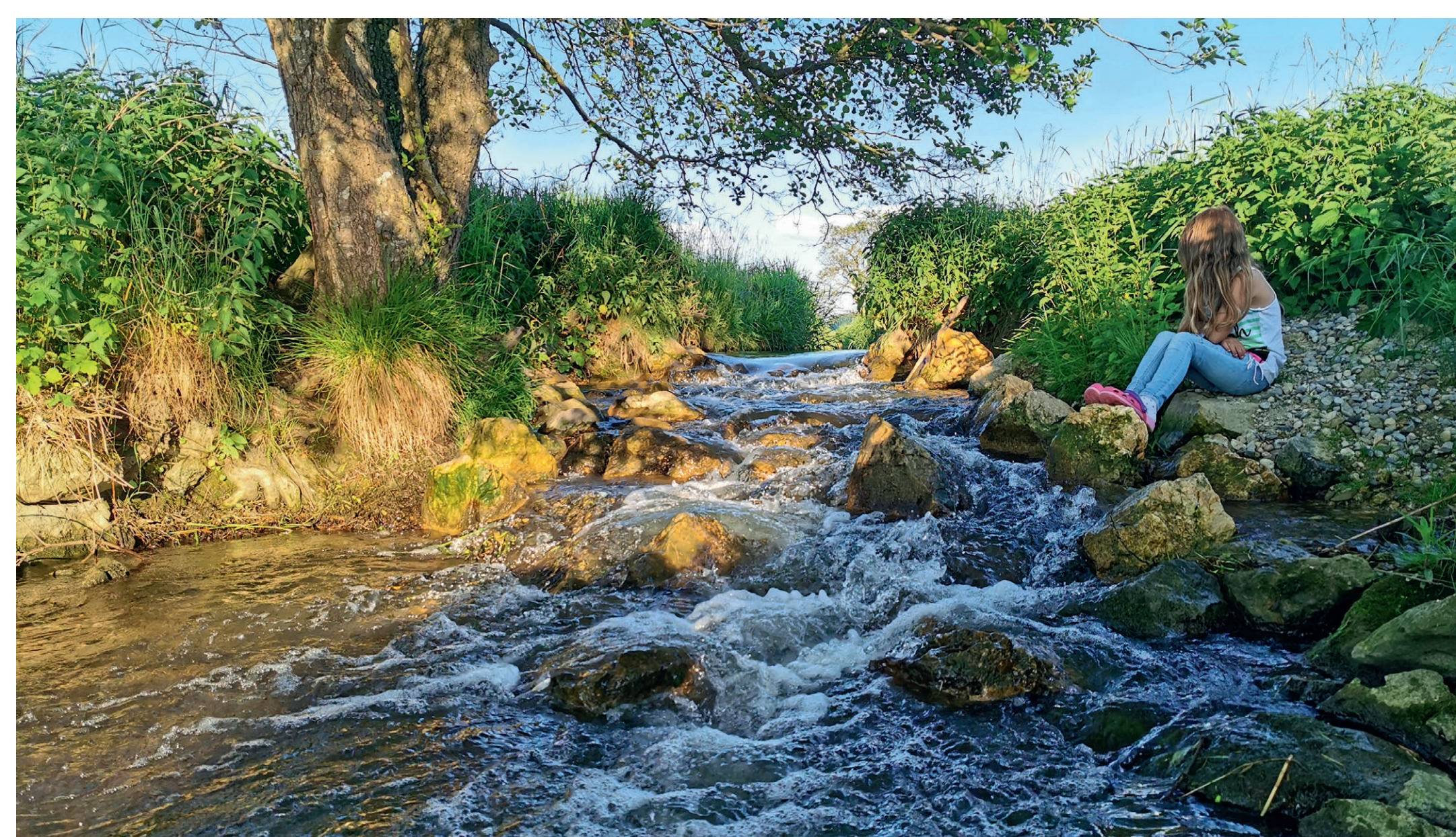
Die neu gestaltete, biologisch durchgängige raue Rampe ersetzt einen vorher nicht durchgängigen Absturz.
