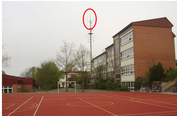
Abb. 5.2: Messung im Außenbereich einer Schule mit Mobilfunkanlage in unmittelbarer Nähe.
