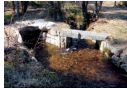
8 Wasserweiche Wohin soll das Holz getriftet werden? Zur Moldau oder über die Hauptwasserscheide zur Donau?
