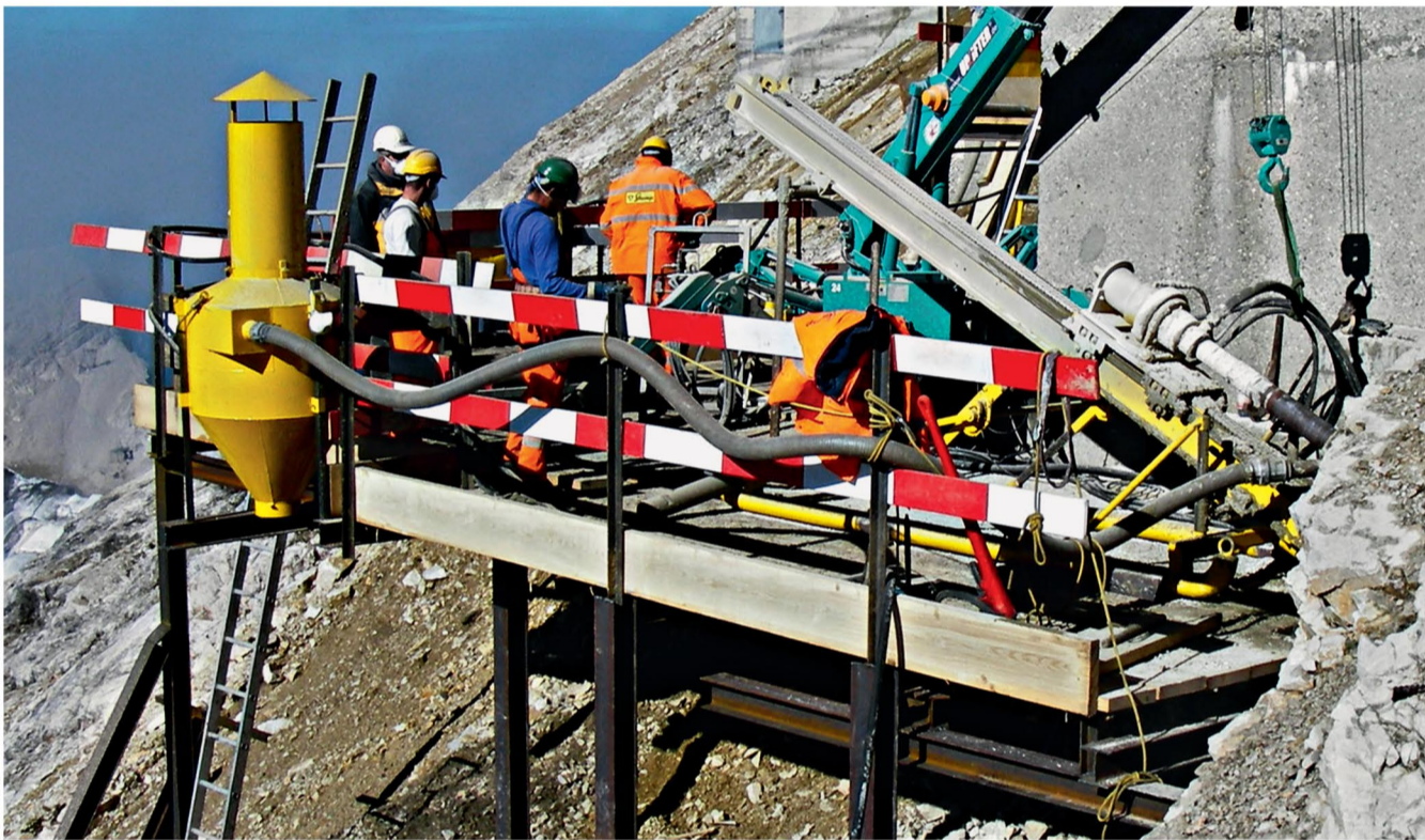
Horizontale Forschungsbohrung durch den Zugspitzgipfel im Jahr 2007.
