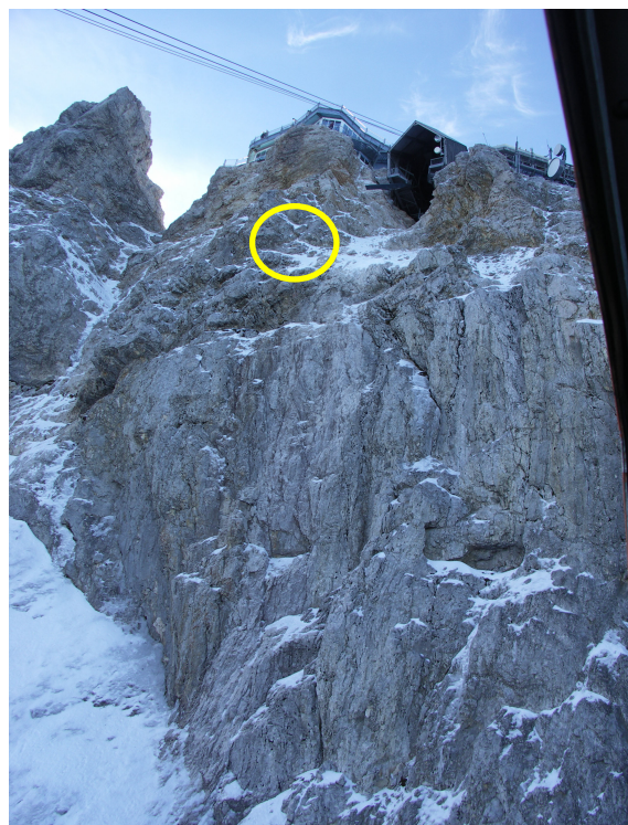
Abb. 4: Blick von Norden von unten in Richtung Gipfelstation. Im gekennzeichneten Bereich soll die Bohrung den Kamm durchstoßen und muss hier nachträglich verschlossen werden
