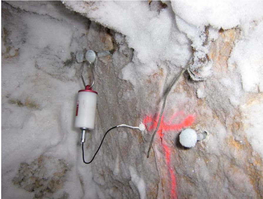
Abb. 6: Im Seitengang installierter Minilogger. Direkt rechts daneben ist eine überreifte Elektrode platziert.
