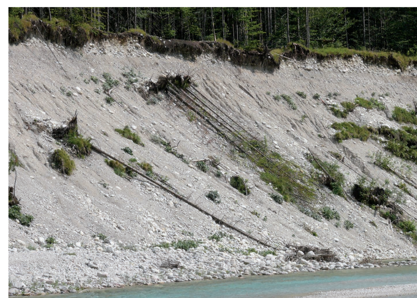
Erosion an einem Prallhang nach einem Hochwasserereignis
