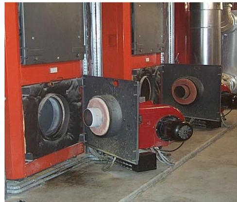
Abb. 4: Beide Kessel nebeneinander mit geöffneten Brennertüren
