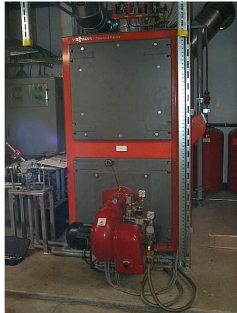
Abb. 3: Rapsölbrenner und -kessel in Frontalansicht
