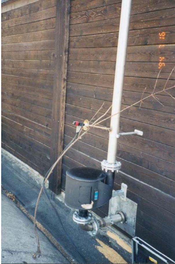
Abbildung 58: Anordnung der Abgas-Messsonde auf Betrieb 4 (Foto vom 29.08.2001)
