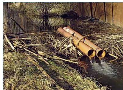
Abb. 18: Rohre im Biberdamm senken den Wasserspiegel.
