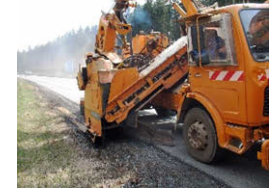
Oberboden Straßenrandbereich Bankettschälgut
