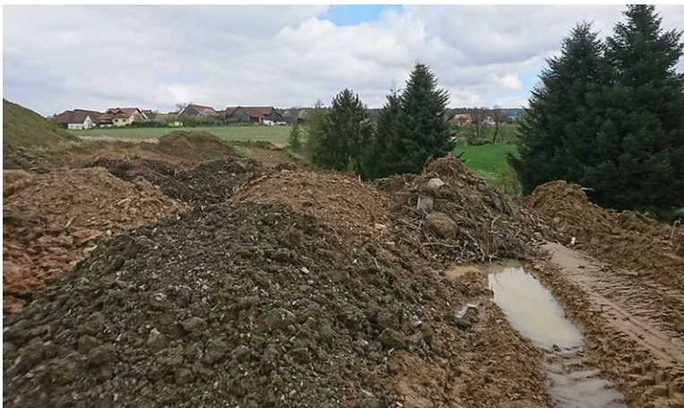
Hoher Fremdstoffanteil, Bodenverdichtung und Pfützenbildung in den Fahrspuren.
