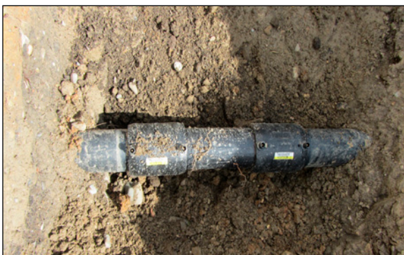
Bild 2: Beispiel für die Sanierung einer Gasleitung
