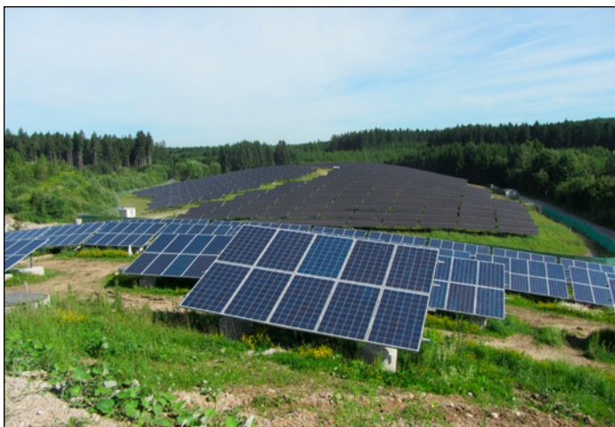
Bild 1: Deponie Schafweide - Neudeponie (im Hintergrund die Altdeponie)
