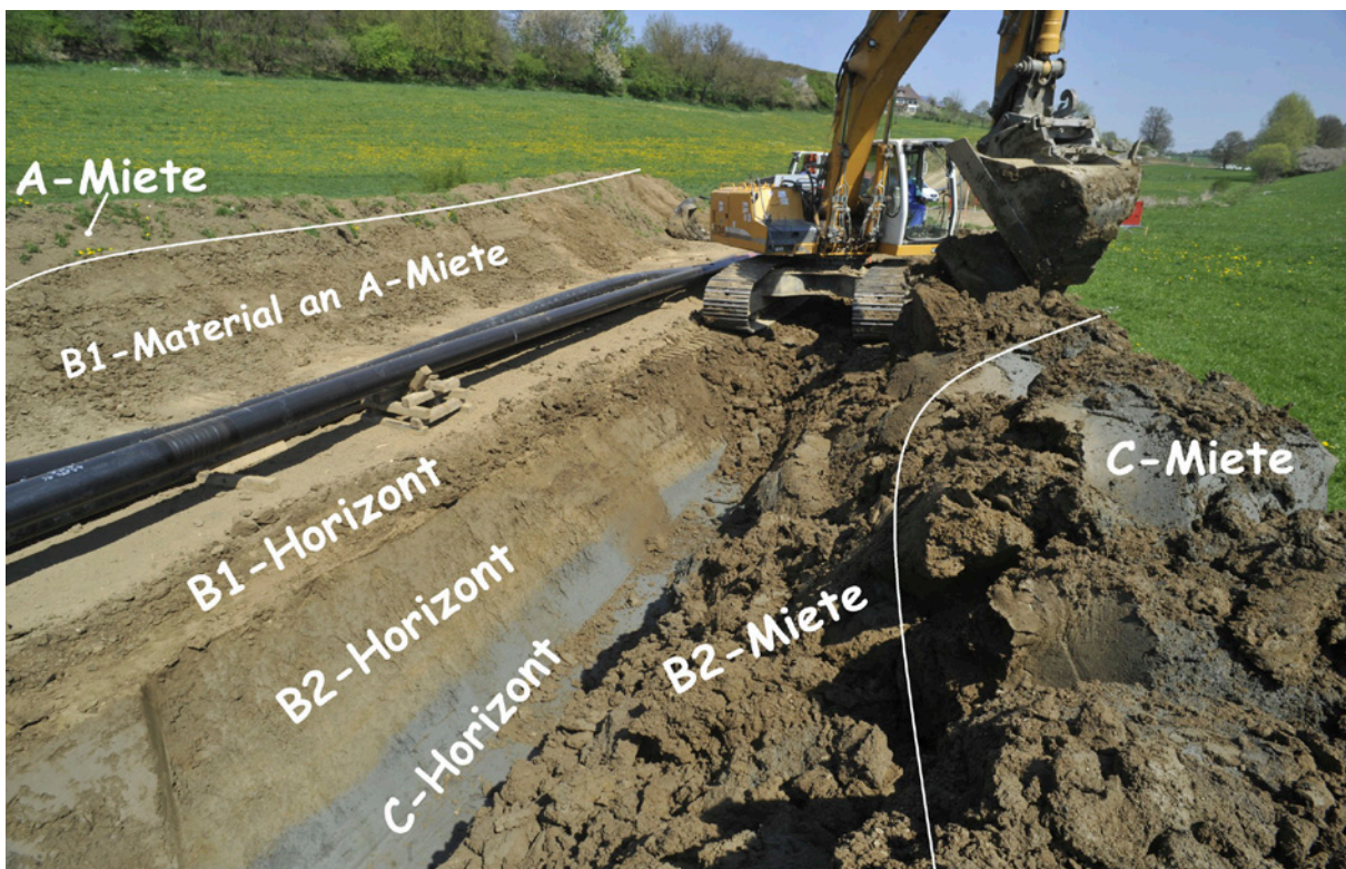
Abbildung 1: Horizontgerechter Ausbau des Rohrgrabens
