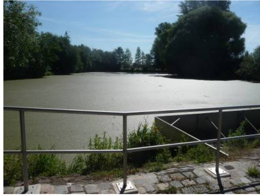
Hochwasser- rückhaltebecken nach Flughafen
