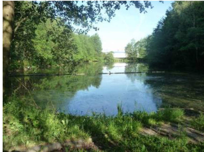
Hochwasser- rückhaltebecken vor Flughafen
