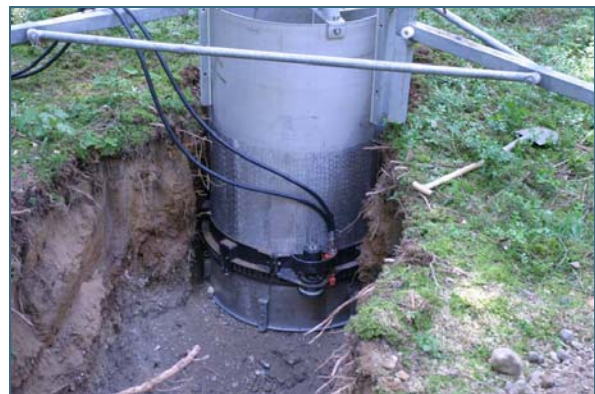
Abb. 2: langsames Hineinfräsen in den Bodenkörper
