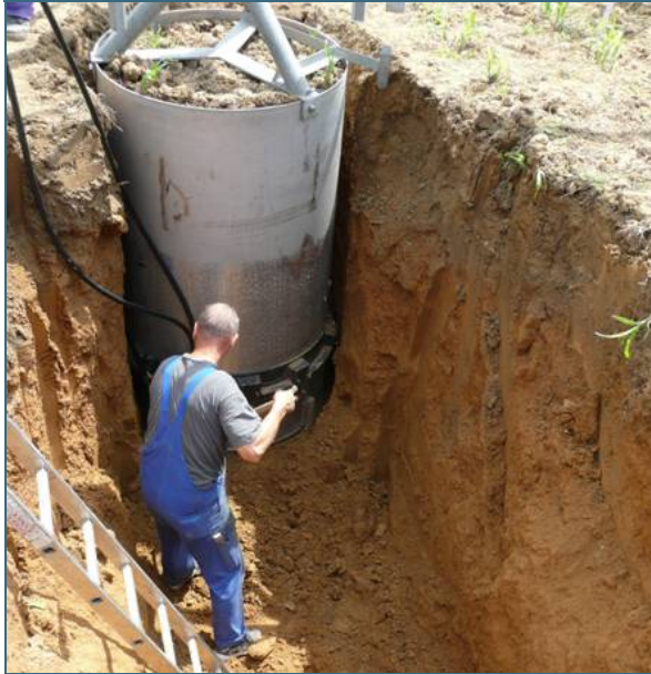
Abb. 3: ...bis zu einer Tiefe von 2 m
