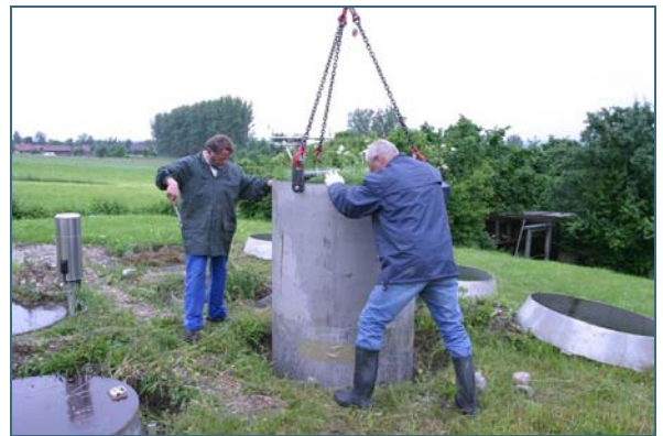
Abb. 6: einsetzen in die Lysimeteranlage
