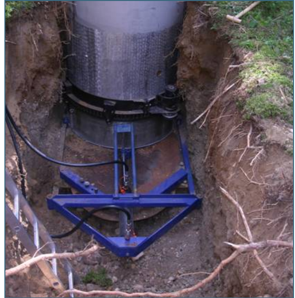
Abb. 4: hydraulisches Abschneiden vom Bodenkörper
